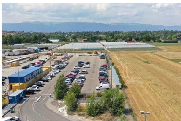
Les Cherpines - vue nord - situation en août 2022
